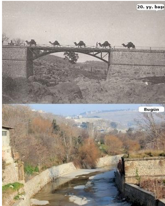
Resim 28, 29 ve 30. Eski Kızılçullu Köprüsü'nün yıkılmadan önceki hali ve günümüzdeki izleri.
