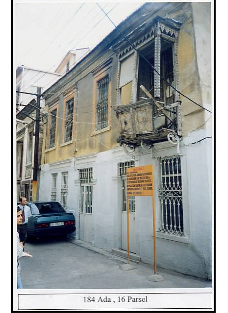
Fotoğraf 4.11 Triko Atölyelerinin Bulunduğu Kesimde Bir Yapı - 184 ada, 16 parsel
