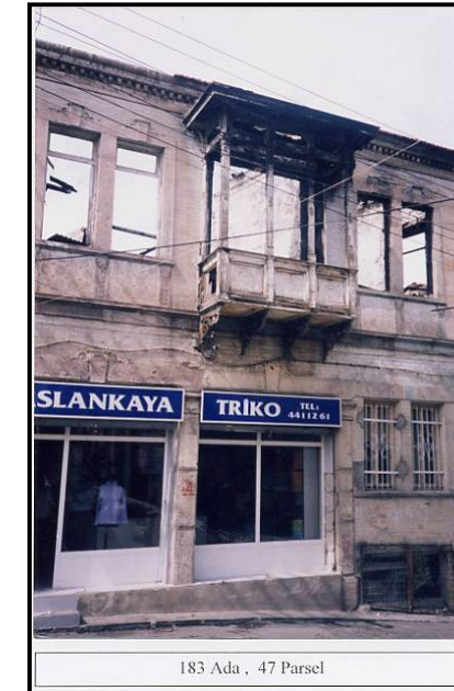
Fotoğraf 4.12 Triko Atölyelerinin Bulunduğu Kesimde Bir Yapı - 183 ada, 47 parsel
